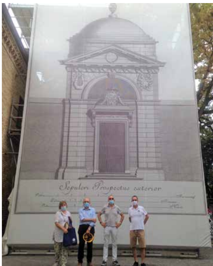
Licia Rubbi, Pierpaolo Burioli, Renzo Valmori e Marcello Monte in visita al cantiere del restauro
